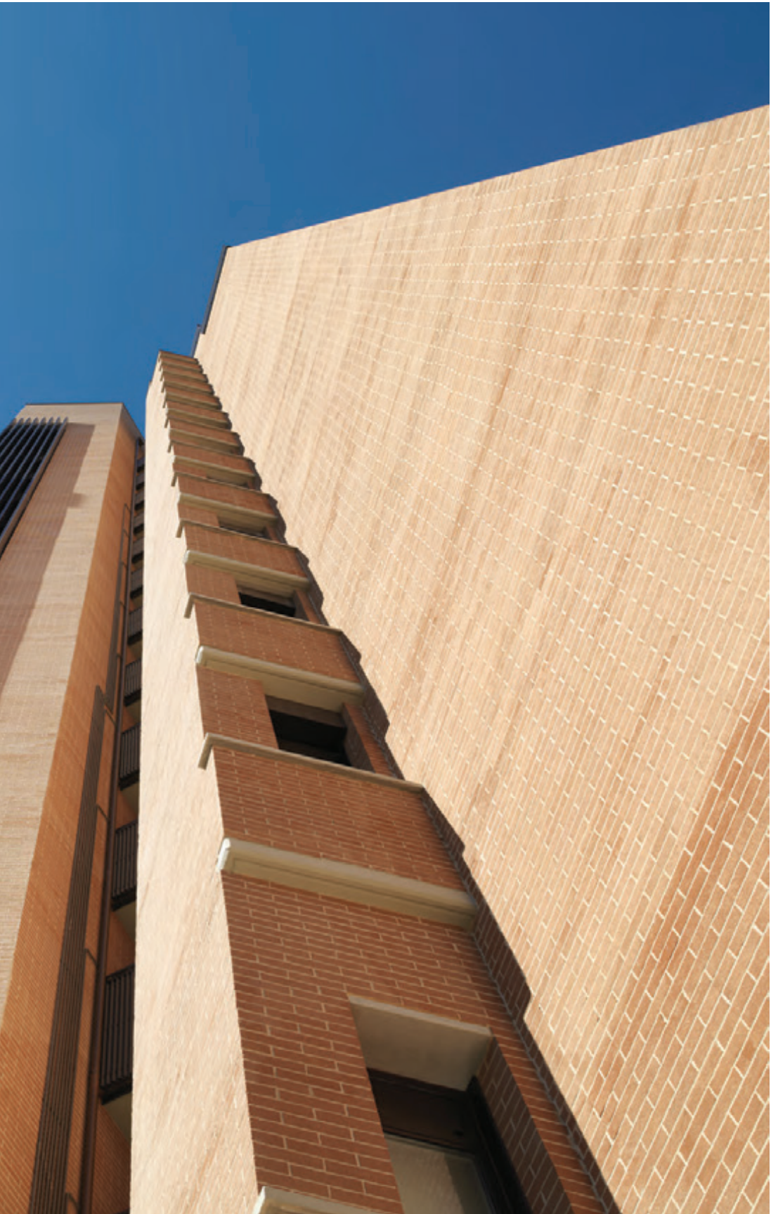
Centro residenziale Imola 2000, Imola (BO) - Felsineo rosso rustico . Imola 2000 residential area, Imola (BO) - rustic red Felsineo
